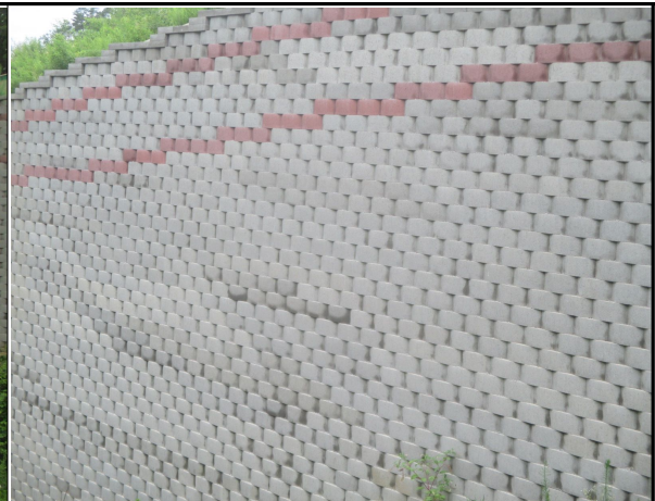
STA.6+083~6+260 옹벽 시공 상태(원주방향)
