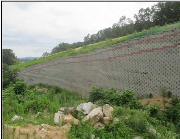
STA.6+083~6+260 옹벽 전경(원주방향)
