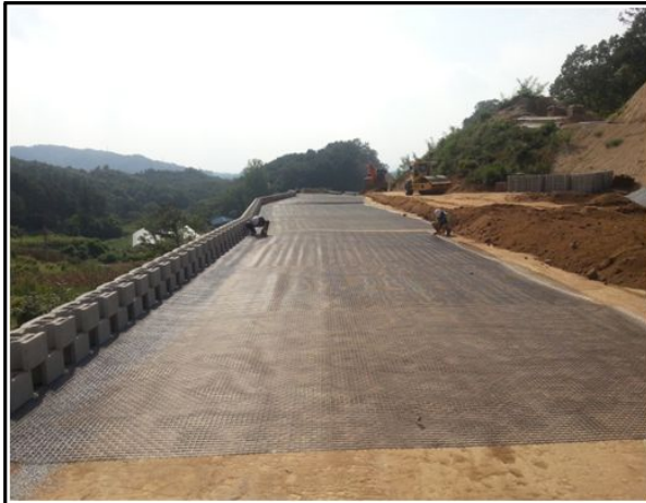
STA.6+083~6+260 그리드 길이 측정(원주방향)
