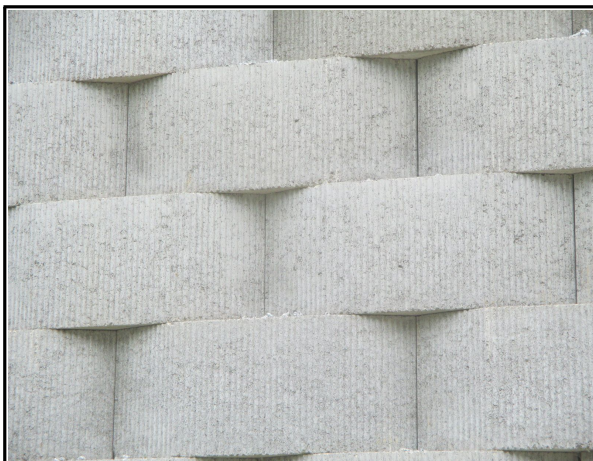
STA.6+083~6+260 옹벽 시공 상태(원주방향)
