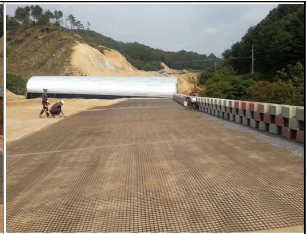
STA.6+083~6+260 그리드 길이 측정(원주방향)
